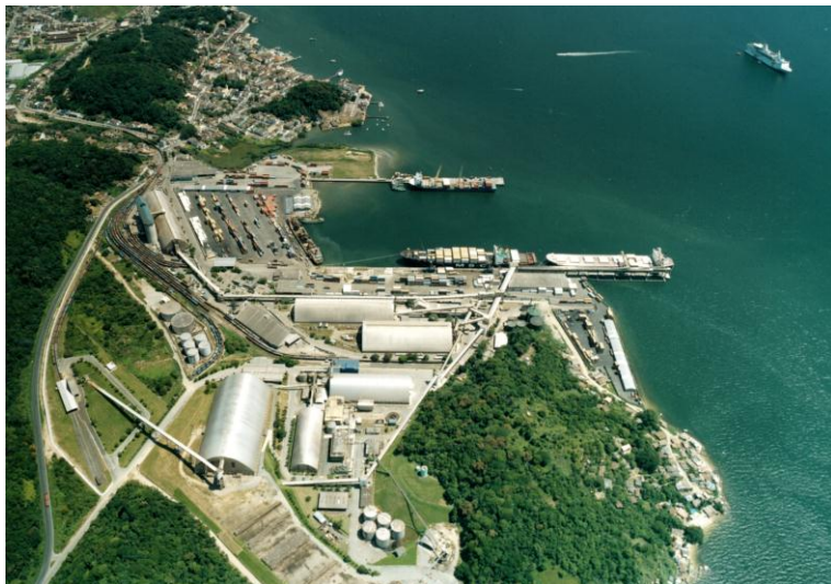
FIGURA 35 // Visão geral do Porto de São Francisco do Sul
