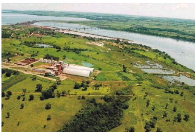
FIGURA 59 // Terminal de Três Lagoas
