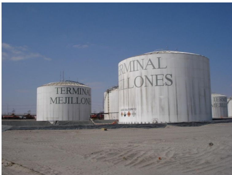
FIGURA 46 // Tanques de Ácido Sulfúrico
