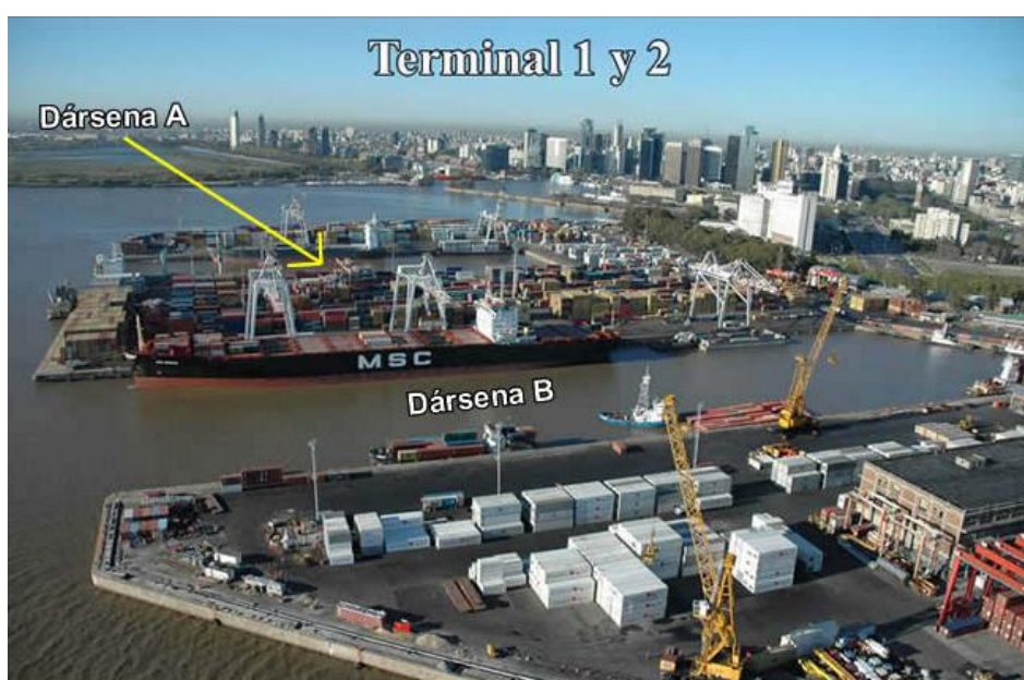
FIGURA 55 // Terminais 1 e 2 do Porto de Buenos Aires
