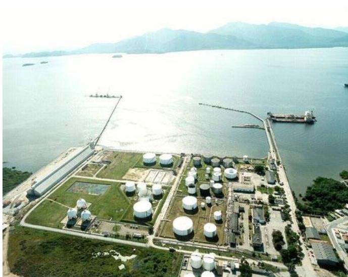
FIGURA 34 // Píer de inflamáveis do Porto de Paranaguá
