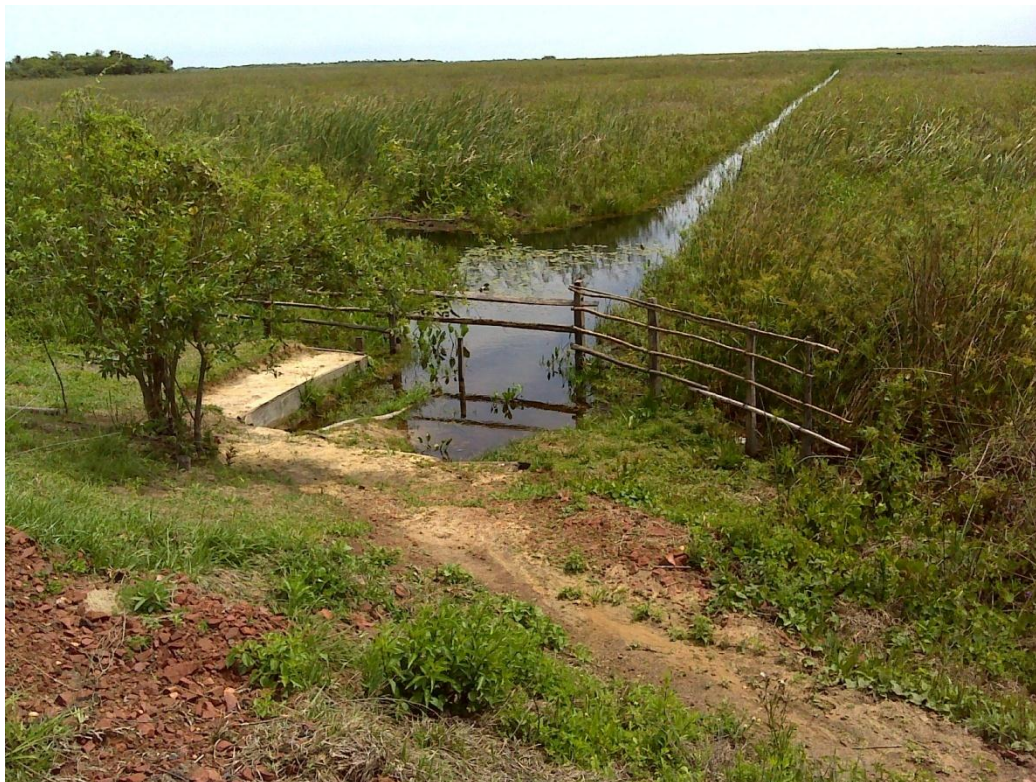
Drenagem na planície alagadiça entre Pilar e km 125,500.
