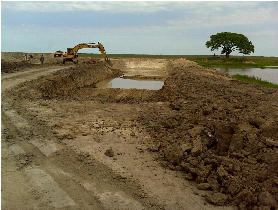
Exploração de jazida de areia e argila no trecho entre Pilar e o km125,500.
