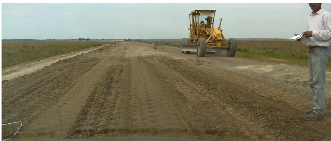
Execução de base de solo-brita na restauração da pista da Ruta 4.
