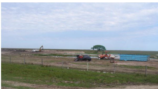
Tratamento de Solo na Ruta 4
