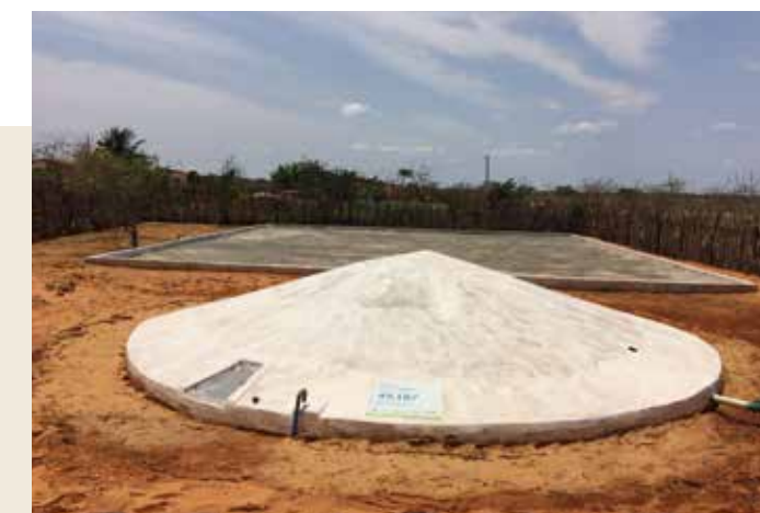
Cisterna no município de Pedro Avelino (RN) possibilita que famílias estoquem água para os períodos de seca. Foto: Luciana Chaves/Acervo BNDES
