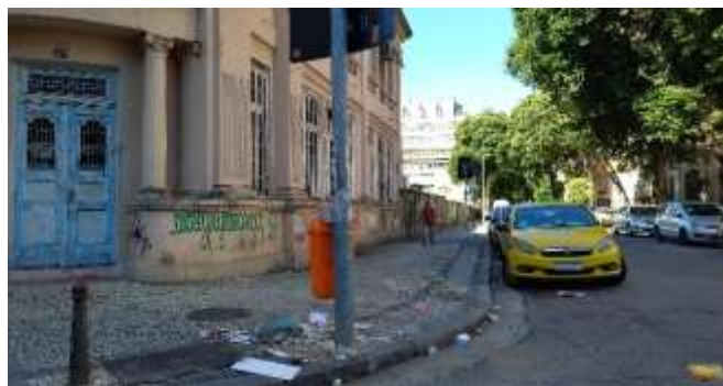
FACHADA COM LOGRADOURO
