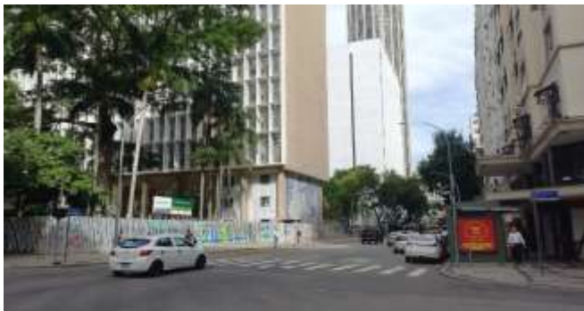
FACHADA COM LOGRADOURO
