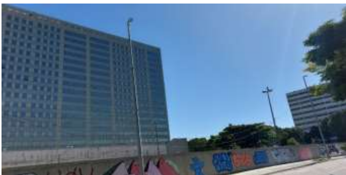
MURO DO TERRENO COM A RUA HAROLDO DE ANDRADE
