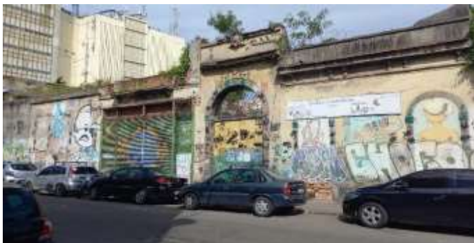
FACHADA COM LOGRADOURO
