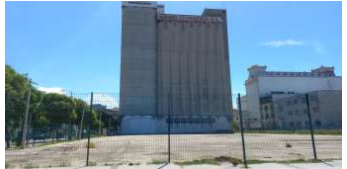
VISTA INTERNA E MOINHO FLUMINENSE AO FUNDO
