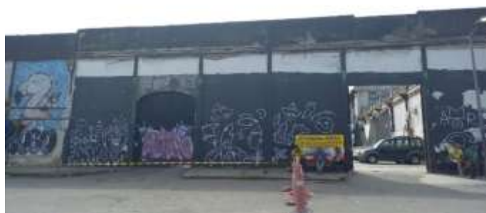
FACHADA - RUA EQUADOR
