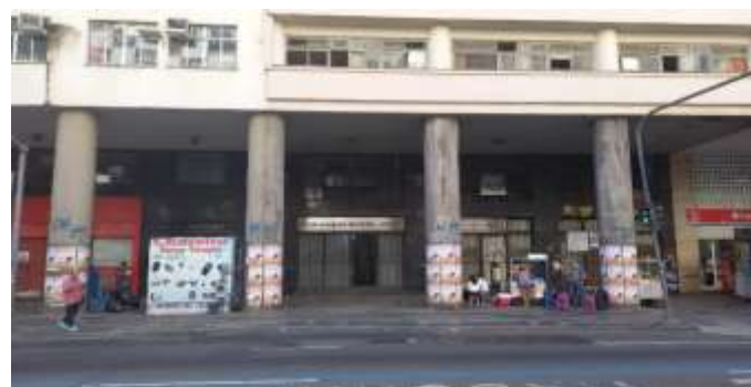
FACHADA E ACESSO - ANDAR TÉRREO
