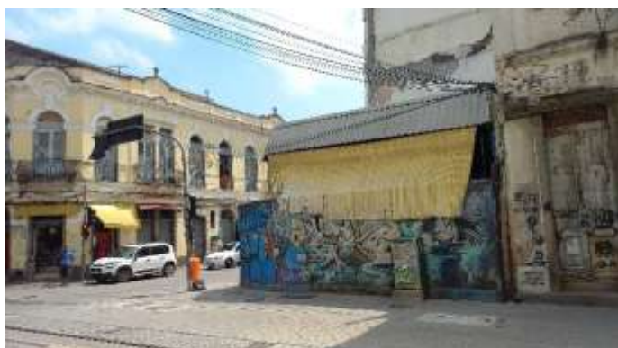
FACHADA COM LOGRADOURO
