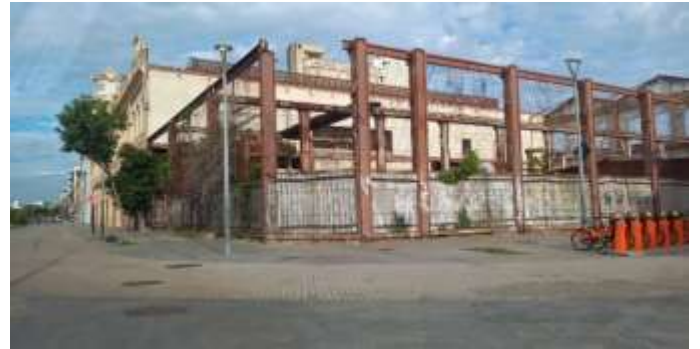
FACHADA COM LOGRADOURO
