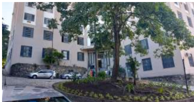
FACHADA E ACESSO
