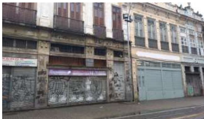
FACHADA DOS IMÓVEIS VIZINHOS
