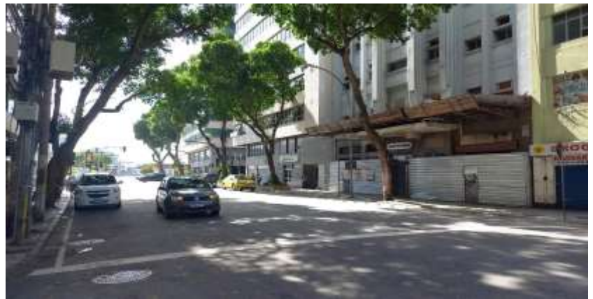
FACHADA COM LOGRADOURO
