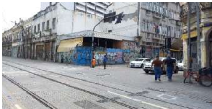
FACHADA COM LOGRADOURO
