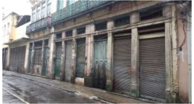
FACHADA COM LOGRADOURO
