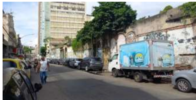
FACHADA COM LOGRADOURO
