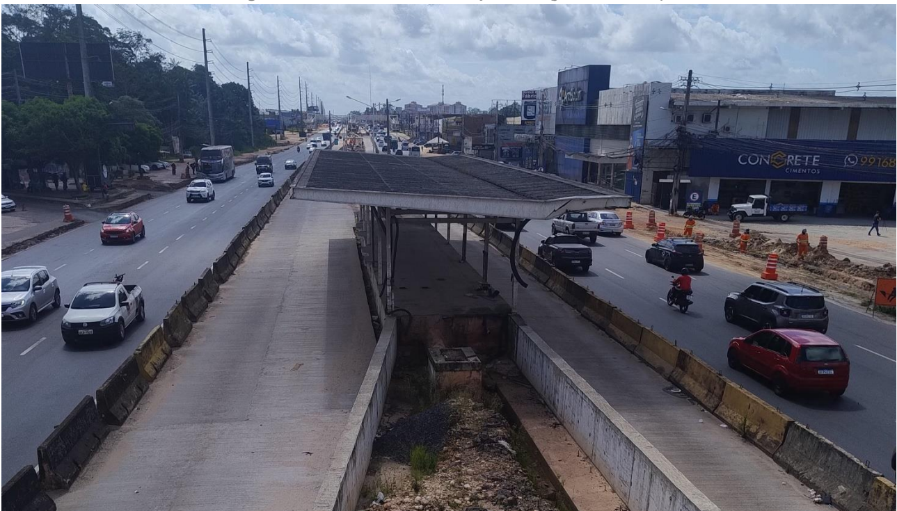
Figura 14: Obras do BRT Metropolitano (julho de 2024)
