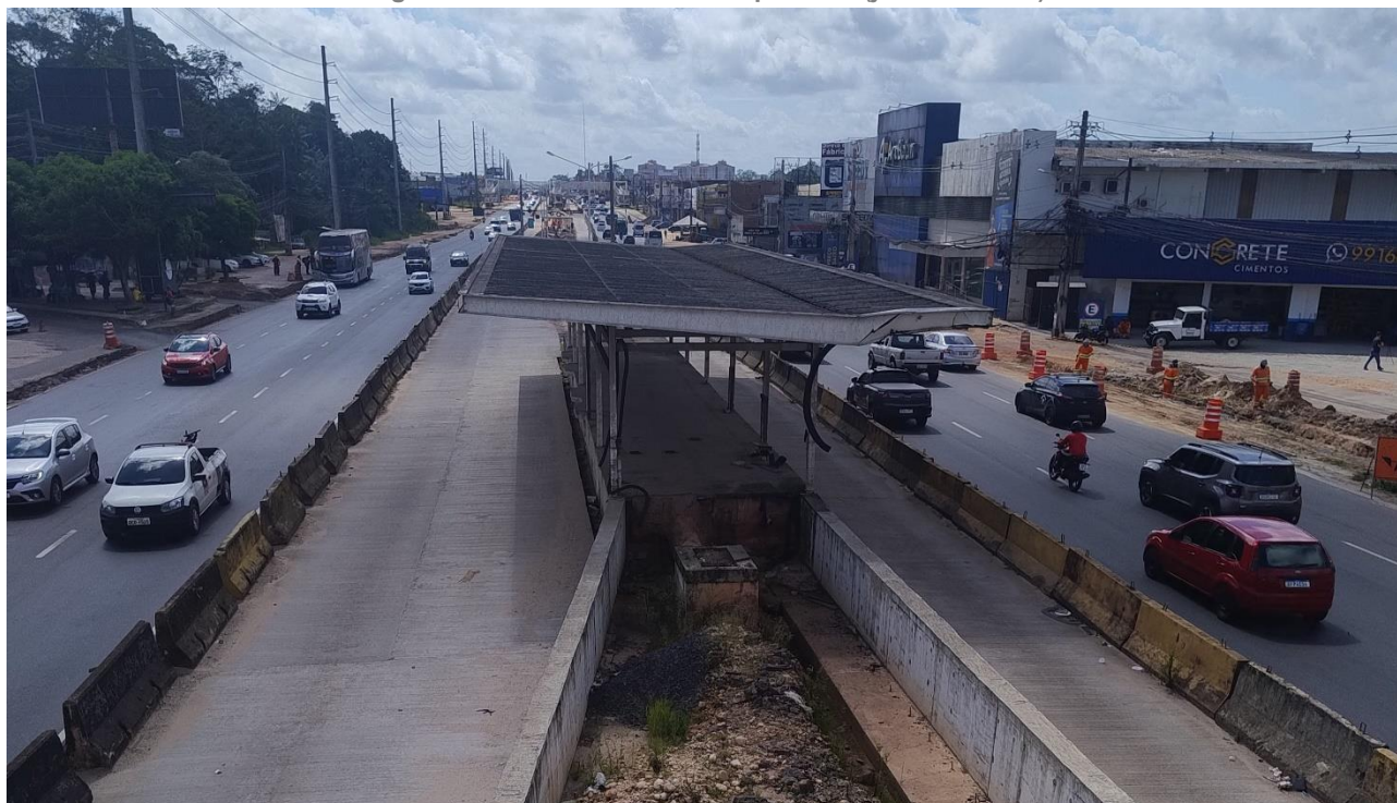
Figura 36: Obras do BRT Metropolitano (julho de 2024)
