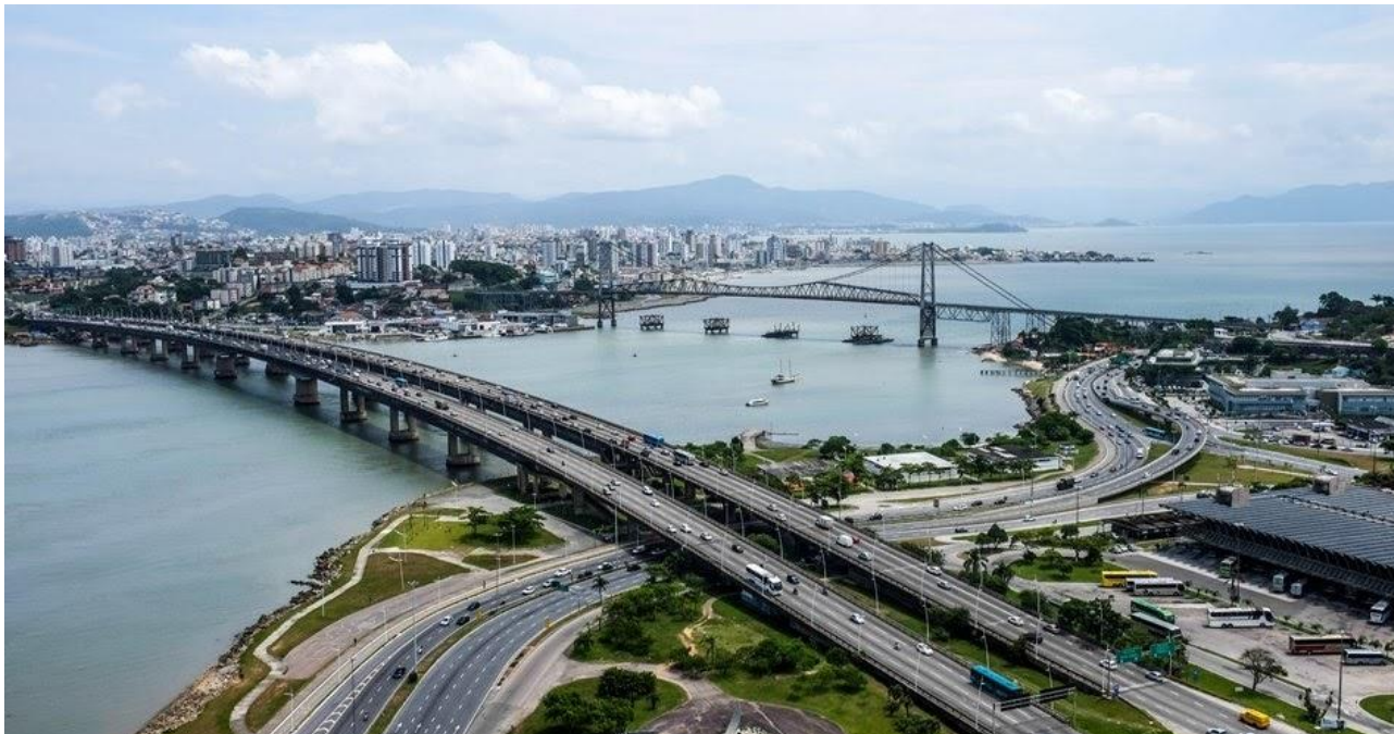
Figura 7: Vista das três pontes que fazem a ligação entre a ilha de Santa Catarina e a porção continental de Florianópolis
