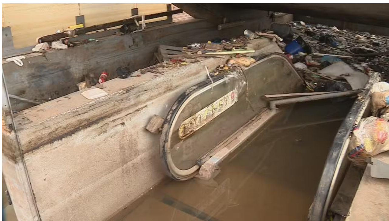
Figura 48: Acesso da Estação Mercado
