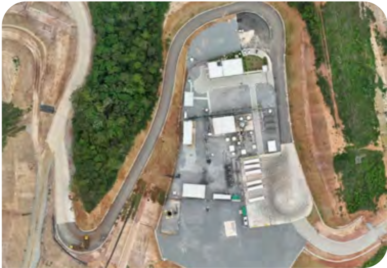
▲ A usina de biometano em Caieiras recebe resíduos de municípios da região metropolitana de São Paulo e da própria capital. Foto: Essencis Biometano S.A.
